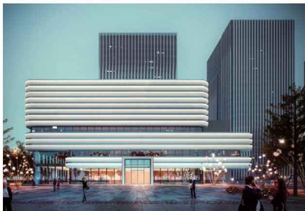
新发展楷林广场会议中心的织物幕墙系统
